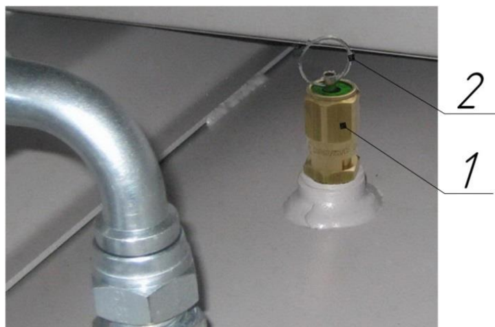
Рисунок 9 – Клапан предохранительный пружинного типа
